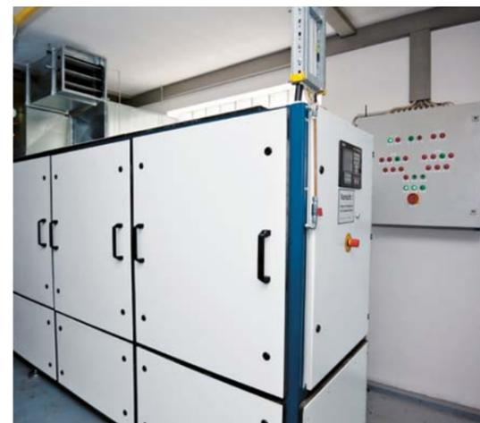
Mini-Blockheizkraftwerke erzeugen nach dem Prinzip der Kraft-Wärme-Kopplung sowohl Strom als auch Wärme.
